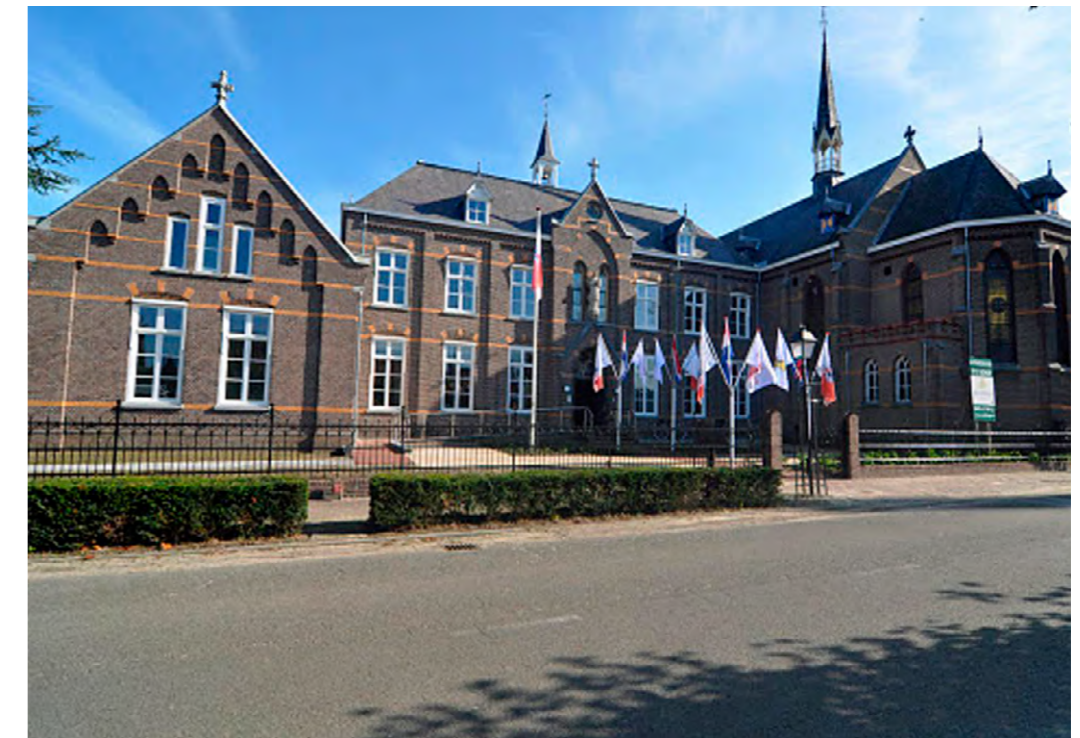
Gemeente Veghel en het schoolbestuur van Basisschool Edith Stein hebben deze een oud klooster tot energiezuinige en frisse school (MFA) verbouwd. In 2012 kreeg de school hiervoor de prijs voor de 'Friste School' van het Platform Binnenmilieu Scholen.
